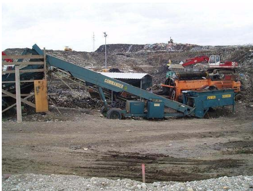
Slika 12: Sanacija Stare deponije v Čakovcu
