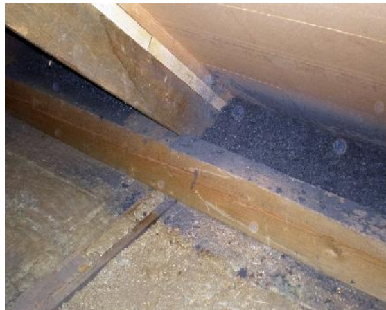
UPORABA ODPADNEGA TEKSTILA V NAMEN IZOLACIJE (IZDELAVA IZOLACIJSKE PENE ALI PLOŠČ)
