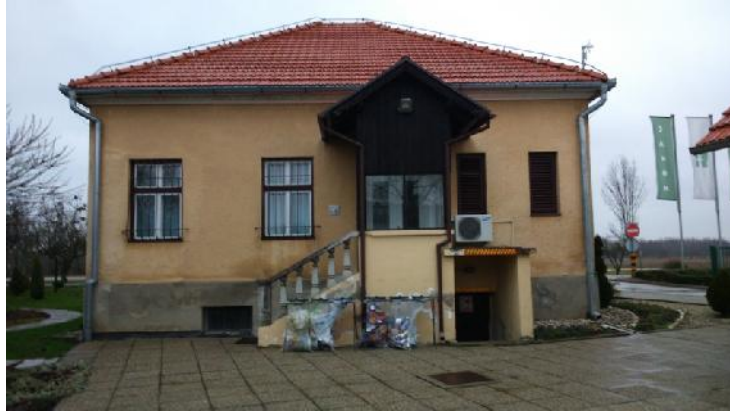
Slika 5: objekt, katerega podstrešje je bilo izolirano
