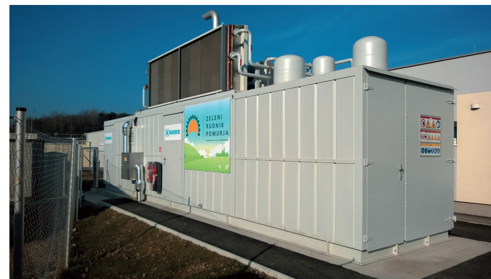
Slika 2: Pogled na sodobno kogeneracijsko napravo v okviru Zelenega rudnika Pomurja
