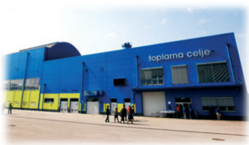
Slika 2: Objekt Toplarne Celje
