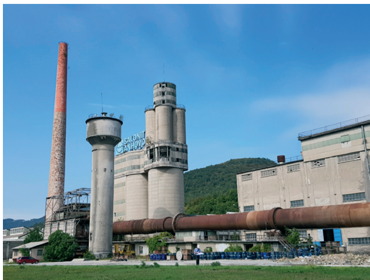
Foto 2: Stara cementarna Polje pred začetkom rušenja in urejanja območja.
