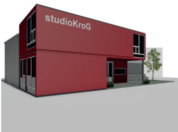
Slika 1: Zasnova modularne gradnje »studioKroG« (100 m 2 ) iz rabljenih ladijskih kontejnerjev v Rogaški Slatini (Zbirni center OKP- CPU Rogaška Slatina)
