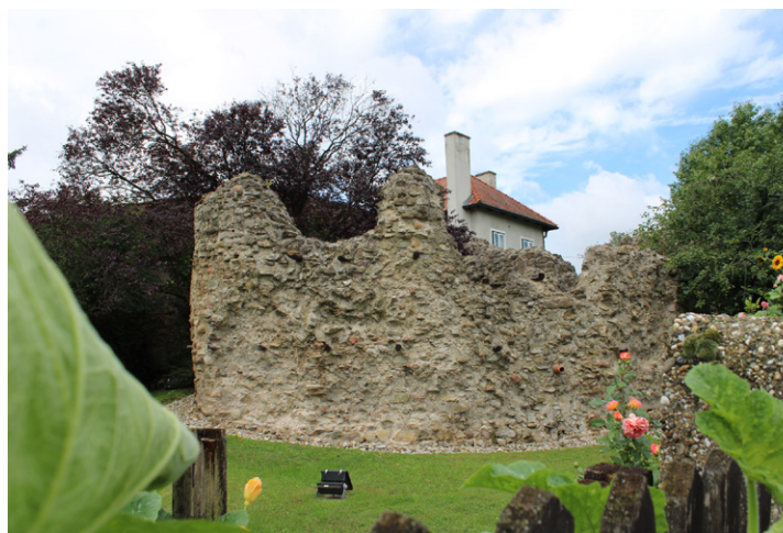
Zeiselmauer Fan Tower
