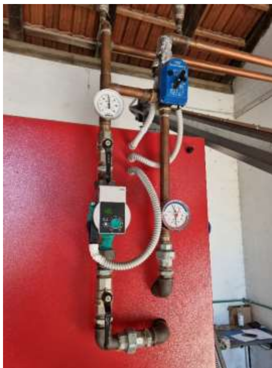
Slika 4: Toplovodni sistem iz pirolizne peči.
